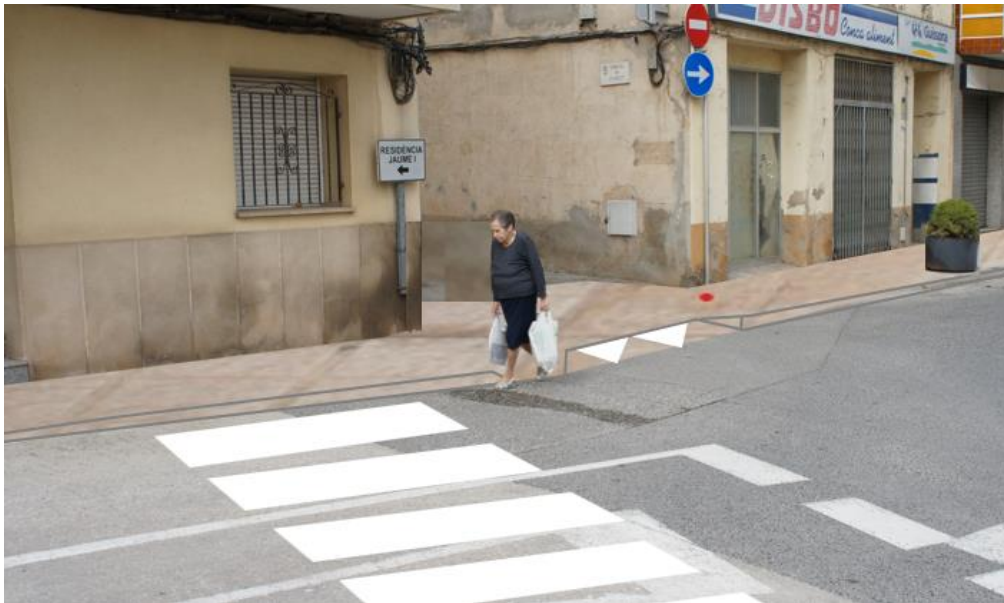
Figura 27. Fotomuntatge plataforma en prolongació i nou pas de vianants, carretera del Poblet amb travessera del Poblet
