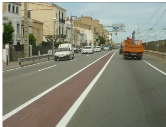
Imatge 61. Exemples de mesures de fàcil aplicació per l'estretament d'amples de calçada
