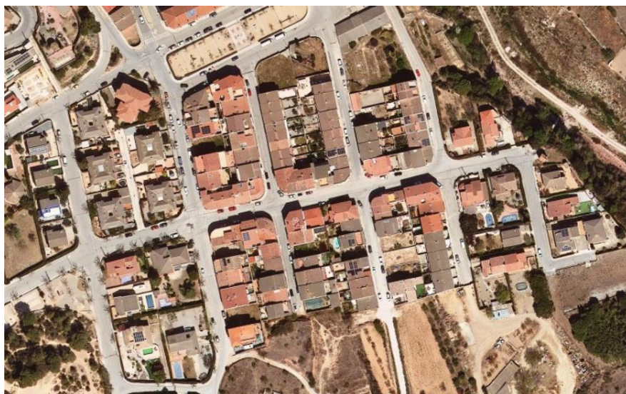
Imatge 17. Manca de passos de vianants, urbanització els Casals
