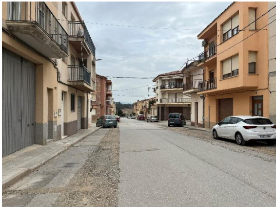
Imatge 54. Exemple de cruïlla urbanització Carrera, intersecció sense passos de vianants i ferm en mal estat
