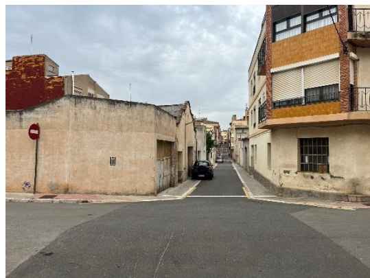
Imatge 19. Cruïlla carrer d'Anselm Clavé amb carreter de les Sortetes, manca de passos de vianants
