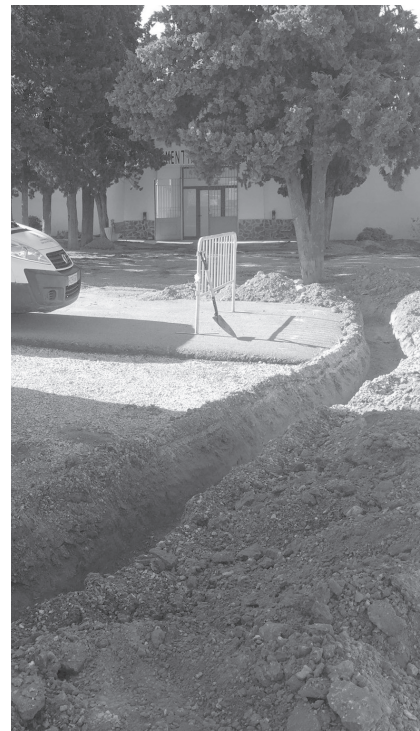
COL·LOCACIÓ DE LA IL·LUMINACIÓ EXTERIOR DEL CEMENTIRI.
