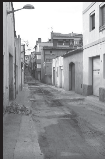
ELS CARRERS EN OBRES.
