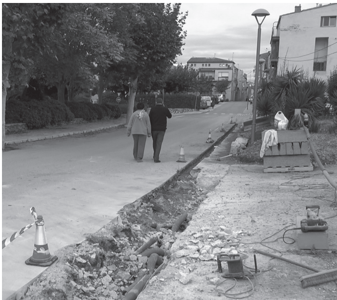
CONSTRUCCIÓ DE LA VORERA DE LA CARRETERA DE POBLET.
