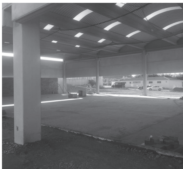
LES OBRES DEL NOU PAVELLÓ. FOTO: Jordi Torre
