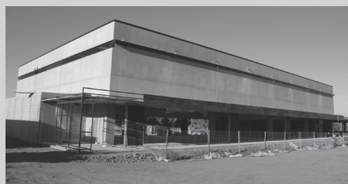
FASE FINAL DE LA CONSTRUCCIÓ DEL PAVELLÓ. Foto: Gerard Bosch
