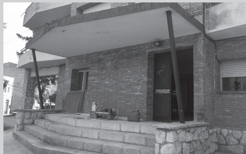
REFORMES A L'ANTIGA CASERNA. Foto: Jordi Torre
