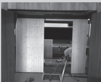
LA NOVA SALA TÈCNICA DEL TEATRE DEL CASAL. Foto: Jordi Torre
