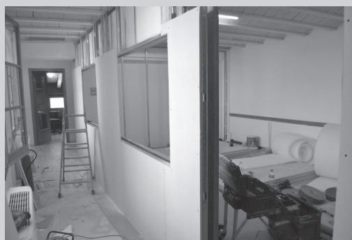
CONSTRUCCIÓ DEL NOU ESTUDI DE L'EFMR.
