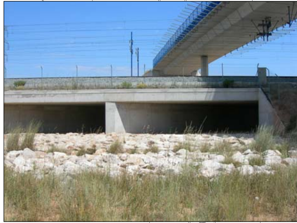
OBRA DRENATGE AVE, PER TOTA L'AIGUA DE LA CONCA
